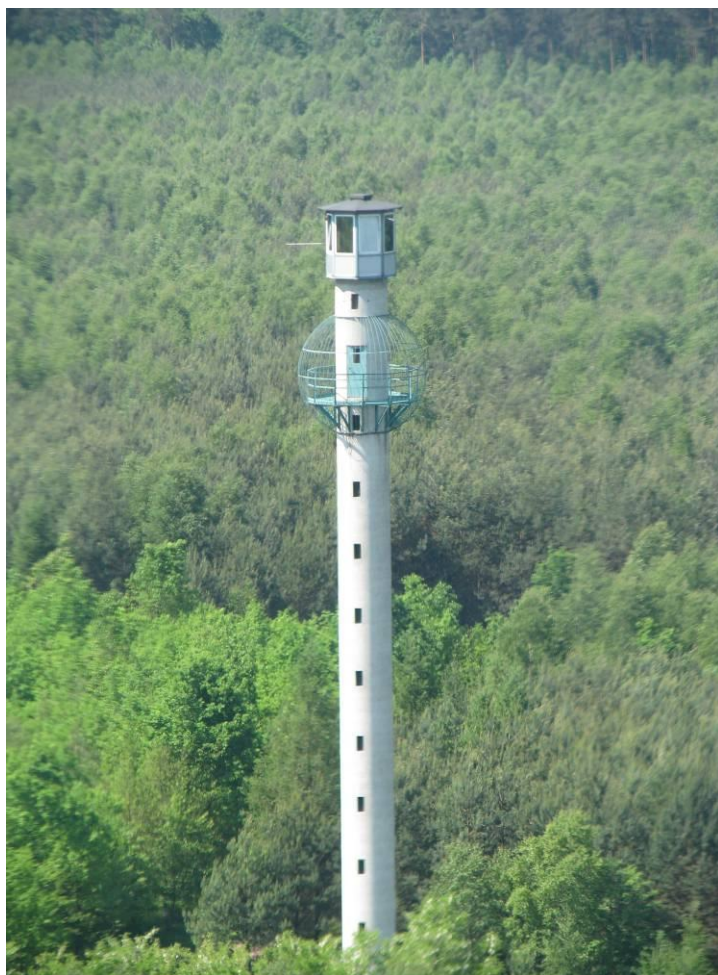
Fot. 4 – dostrzegalnia przeciwpożarowa
